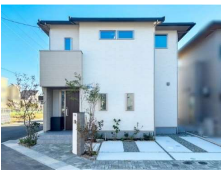
太陽光発電(3.48kW)、オール電化住宅
