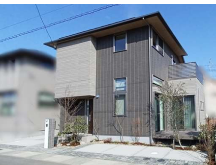
太陽光発電(4.56kW)、オール電化住宅
